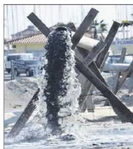
L'eau chargée de son sable est acheminée dans le bassin avant décantation. (Photos C. M.)
